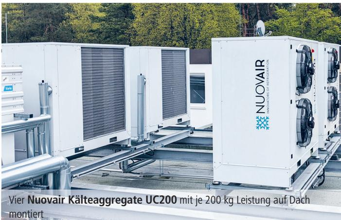
Vier **Nuovair Kälteaggregate UC200** mit je 200 kg Leistung auf Dach montiert
