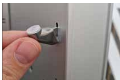
1. Inserire il tondino di alluminio nei fori ricavati nei pannelli centrali in alluminio dal vano destro.
