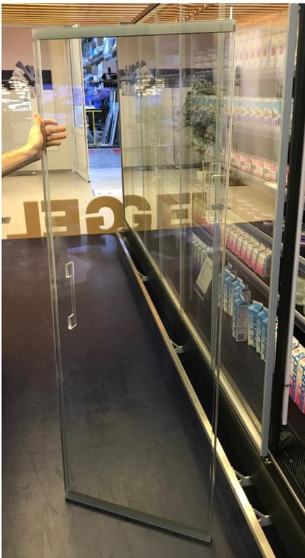
4) Die beschädigte Tür durch eine neue ersetzen.
