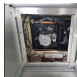
A5. Compartimento del condensador
