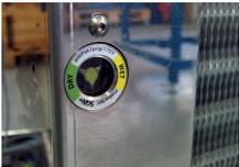
Bei steckerfertigen Geräten sind die Rohrleitungen fix mit dem Kälteaggregat verbunden und der Kältekreislauf mit Kältemittel gefüllt. Vitrinen mit Expansionsventil und ab einer bestimmten Größe verfügen über ein Schauglas mit Feuchteindikator (zur Kontrolle im Servicefall), dieses befindet sich seitlich am Kondensator. Bei steckerfertigen Geräten mit Kältemittel Propan (R290) ist kein Schauglas vorhanden.
